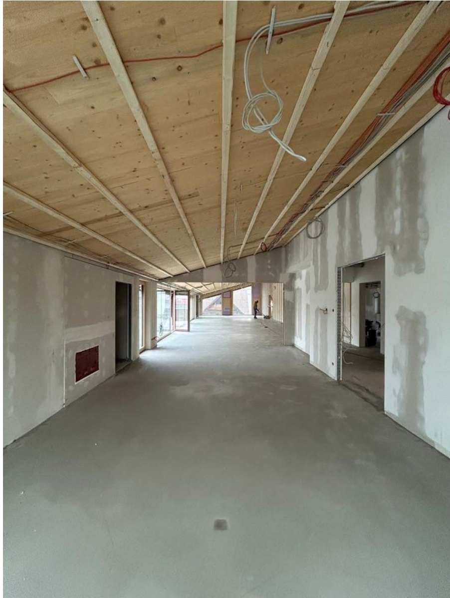
Bereitschaftsraum Blickrichtung zum Schulungssaal
